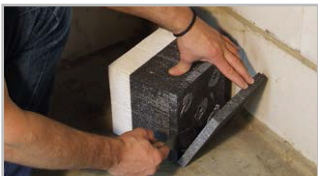
1. Dostosować grubość izolacji, tzn. odciąć płyty izolacyjne 20 mm.
