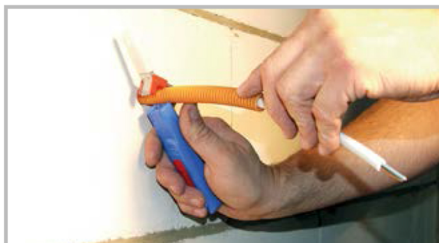
2. Odciąć rurę instalacyjną przy ścianie.
