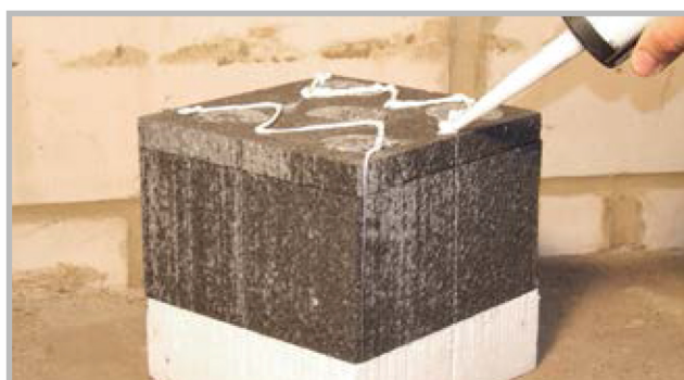
4. Nanieść cienką warstwę kleju hybrydowego TIE dookoła (5-6 mm).
