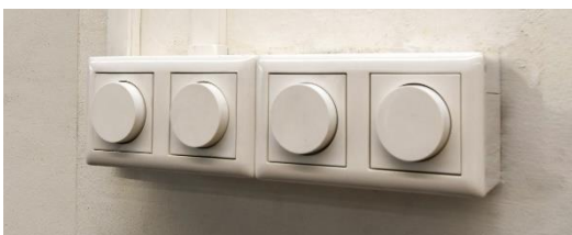
Es wurde eine MCU SELECT DALI-2 Komponente installiert, um das Lichtbandsystem zu dimmen
